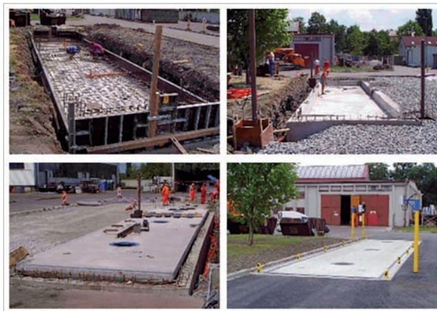
Obr. 43 Monolitický základ
