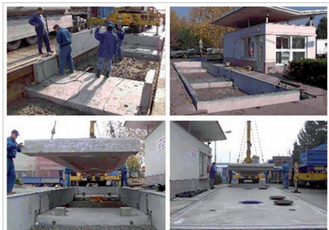
Obr. 42 Prefabrikovaný základ
