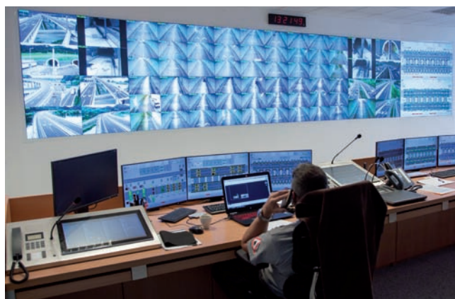
Operátor dopravy môže len prepínať medzi jednotlivými vopred definovanými a schválenými dopravno-prevádzkovými stavmi podľa pravidiel stanovených v prevádzkovom predpise a operatívnych kartách.
